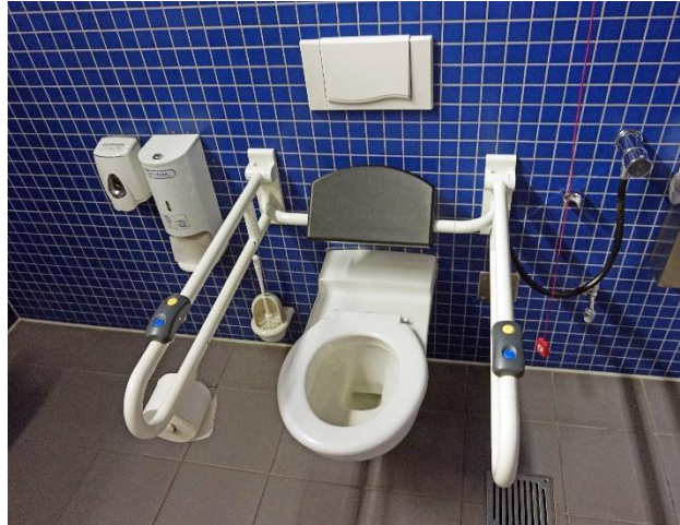
Image 2 - Exemple de toilettes accessibles. Source : Wikipedia
